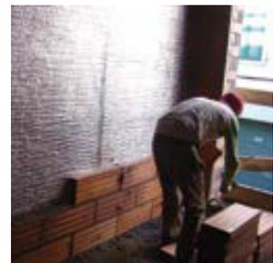
\*Combinación realizada entre aislante Air-bur Termic y un aislante de masa (lana mineral, XPS, EPS... de conductividad térmica 0,036 W/mk).
